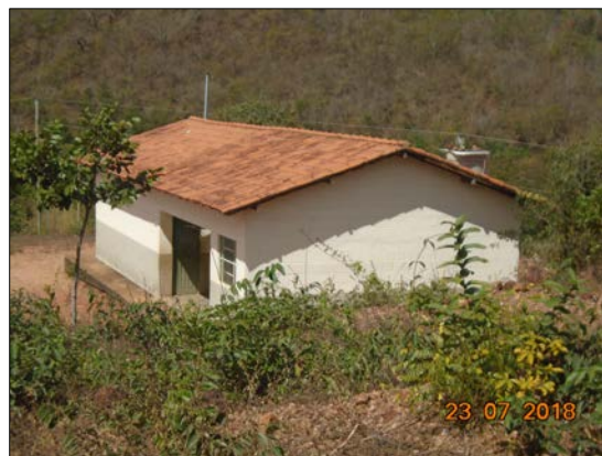
Foto 1.5-13 - Escola rural desativada na localidade de Lamarão
