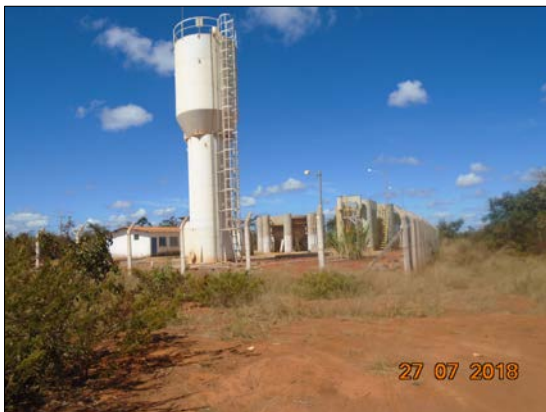
Foto 1.4-5 - Estação de tratamento de água do Vale das Cancelas
