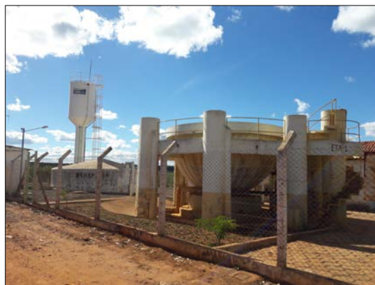
Foto 1.4-2 - Estação de Tratamento de Água (ETA) da sede urbana de Padre Carvalho
