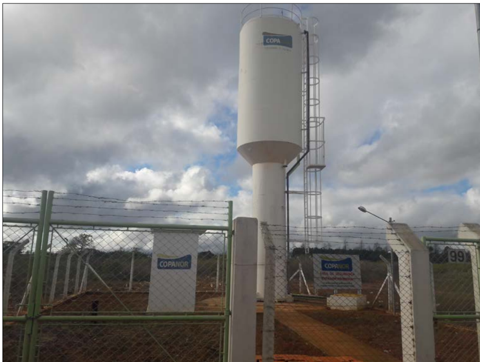
Foto 1.4-7 - Caixa d'Água central do Campo de Vacarias.
