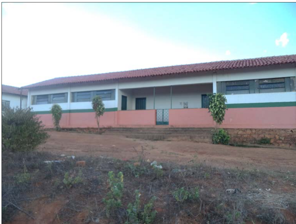
Foto 1.5-9 - Escola de Ensino Fundamental de Vacaria/Ponte Velha
