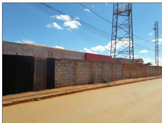
Foto 1.5-8 - Instalações da creche em construção, obra paralisada, no Vale das Cancelas
