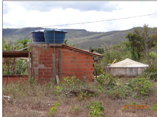
Foto 1.4-13 - Cisterna para coleta e armazenamento da água das chuvas na localidade rural da Fazenda Diamantina
