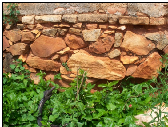
Foto 1.7-2 - Detalhes da construção - base da estrutura Fonte: Brandt Meio Ambiente, 2012
