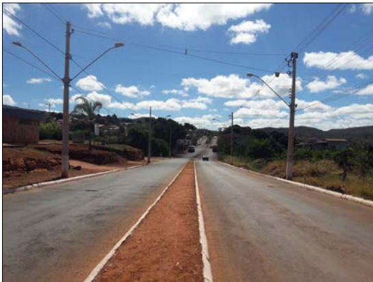
Foto 1.3-7 - Via de acesso principal à sede urbana de Grão Mogol
