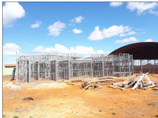
Foto 1.5-16 - Instalações da UBS em construção, obra paralisada, no Vale das Cancelas
