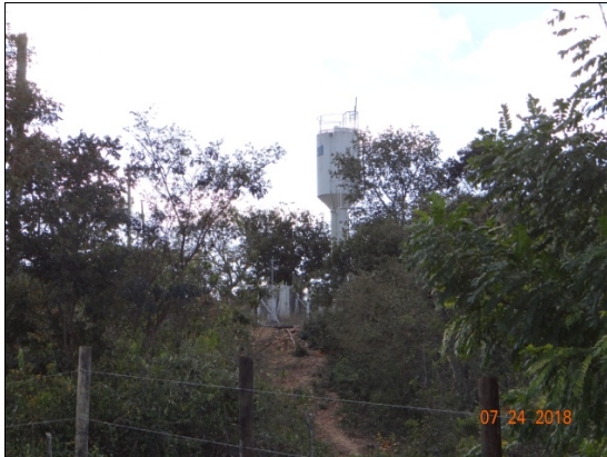
Foto 1.4-12-Caixa d'água de poço "artesiano" (tubulares profundos) comunitário da comunidade de Tamboril
