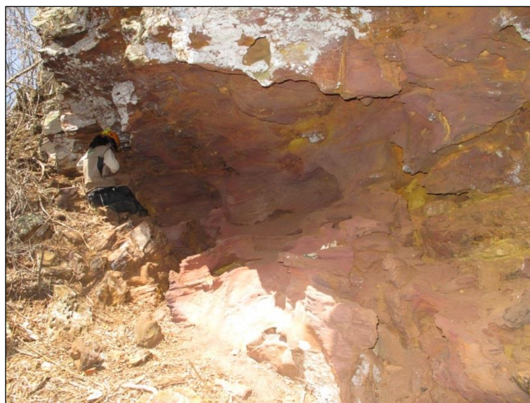
Foto 7.20 - Visão parcial da feição na rocha, associada a processos de abatimento, na feição FE-08. Fonte: Brandt, 2013b.
