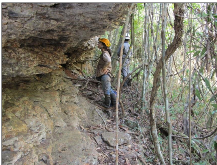
Foto 7.15 - Visão parcial da feição FE-06, onde é possível observar a sua abertura lateral. Fonte: Brandt, 2013b.
