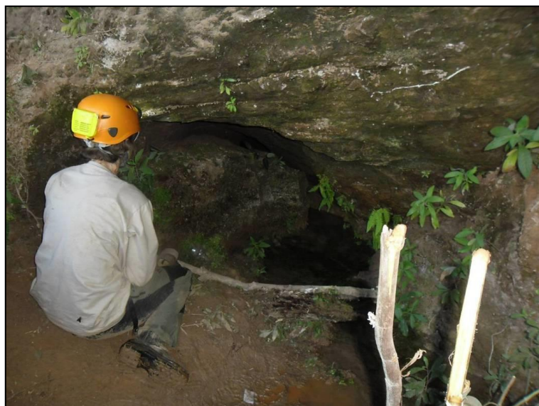
Foto 8.65 - Conduto posicionado em nível inferior com presença de drenagem. Fonte: Brandt, 2012b.
