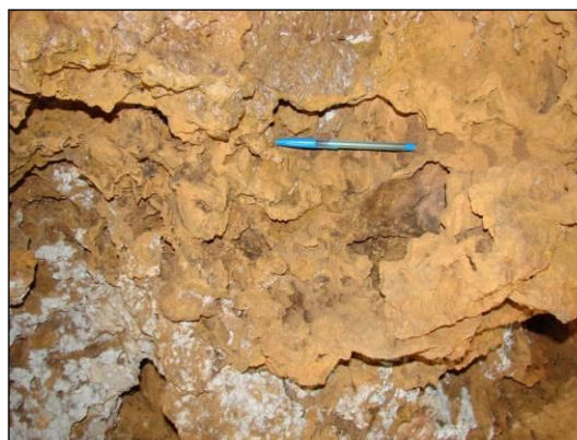
Foto 8.30 - Crostas brancas nas paredes da cavidade.
