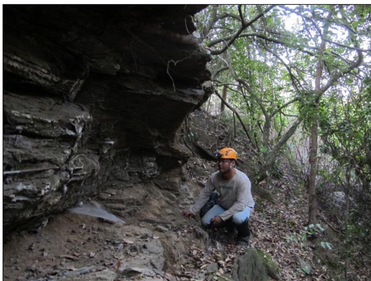
Foto 7.10 - A feição negativa na rocha encontra-se paralela à drenagem local, estando encoberta por mata de galeria secundarizada. Fonte: Brandt, 2013b.
