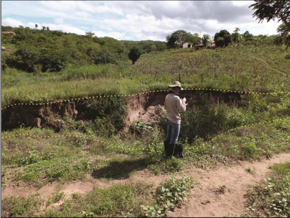
Foto 9.56 - Processos erosivos na forma de voçoroca na margem esquerda de um afluente do rio Vacaria
