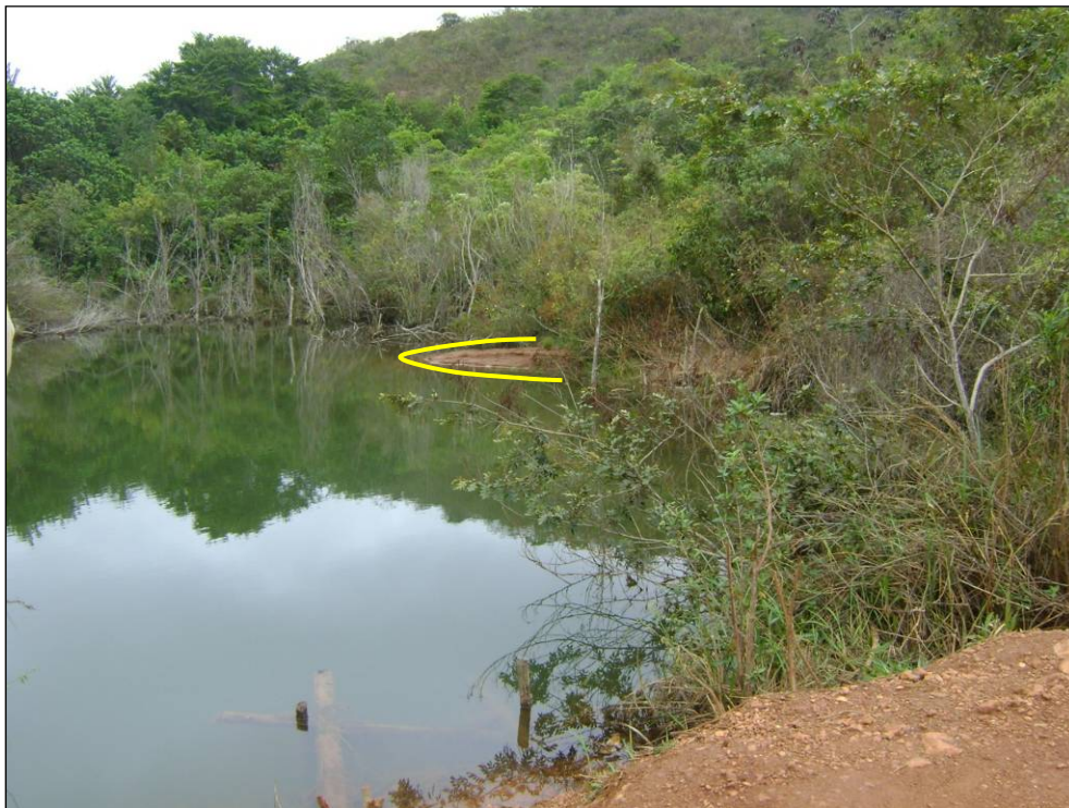
Foto 9.20 - Área assoreada em barragem situada na cabeceira do córrego Mundo Novo, local da futura barragem 2 de rejeitos.
