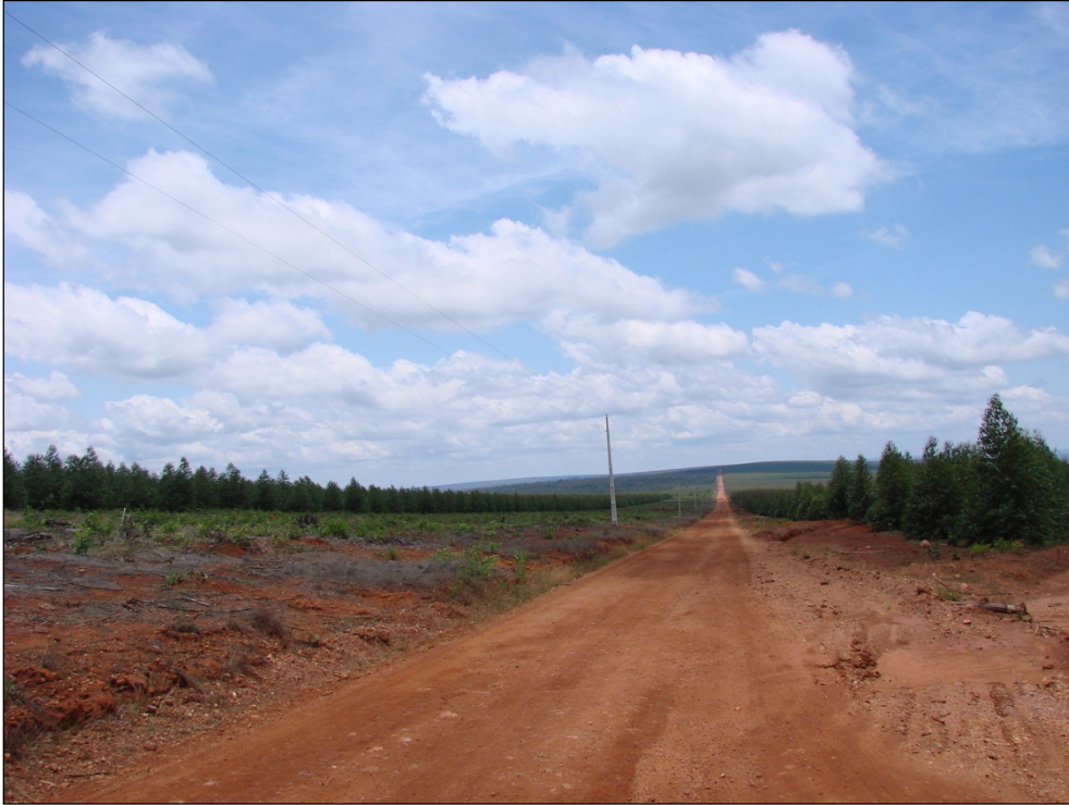
Foto 7.34 - Topo de extenso platô por onde a adutora de Irapé e a linha de transmissão seguirão em seu médio percurso. Vista de norte para sul, aproximadamente
