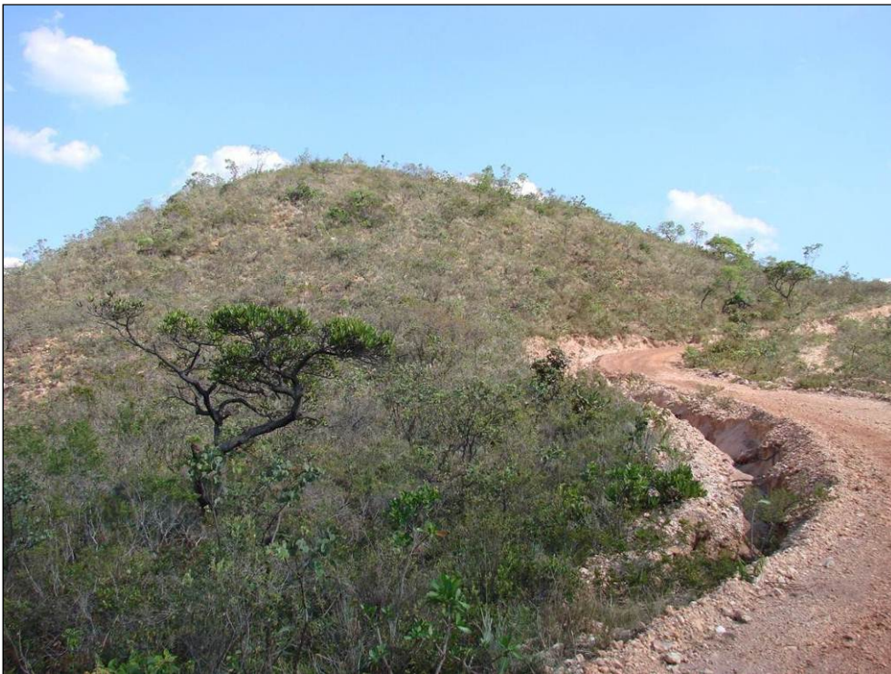
Foto 9.21 - Erosão em sulco em estrada com acesso ao córrego Lamarão, próximo a porção norte da futura cava
