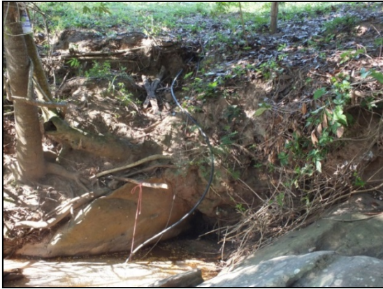
Foto 10.85 - Ponto de captação 1 - Córrego Água Branca
