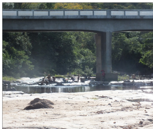
Foto 5.41 - Área sob a ponte onde ocorre lavagem de roupa, à frente a areia retirada do leito do rio (período de seca)
