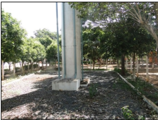
Foto 11.9 - Poço tubular (COPANOR), localizado no centro de Fruta de Leite
