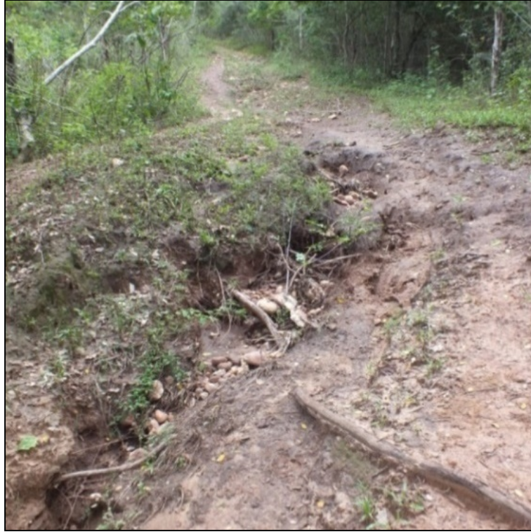
Foto 9.53- Processos erosivos em via local tipicamente na forma de sulcos e ravinas Elaboração, IC Ambiental.
