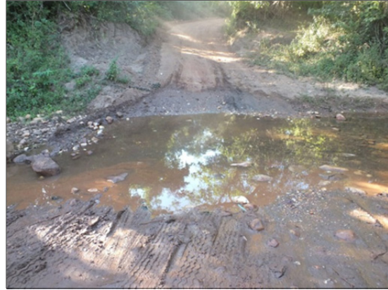
Foto 10.84 - Estrada de acesso às comunidades, que intercepta o Córrego Água Branca
