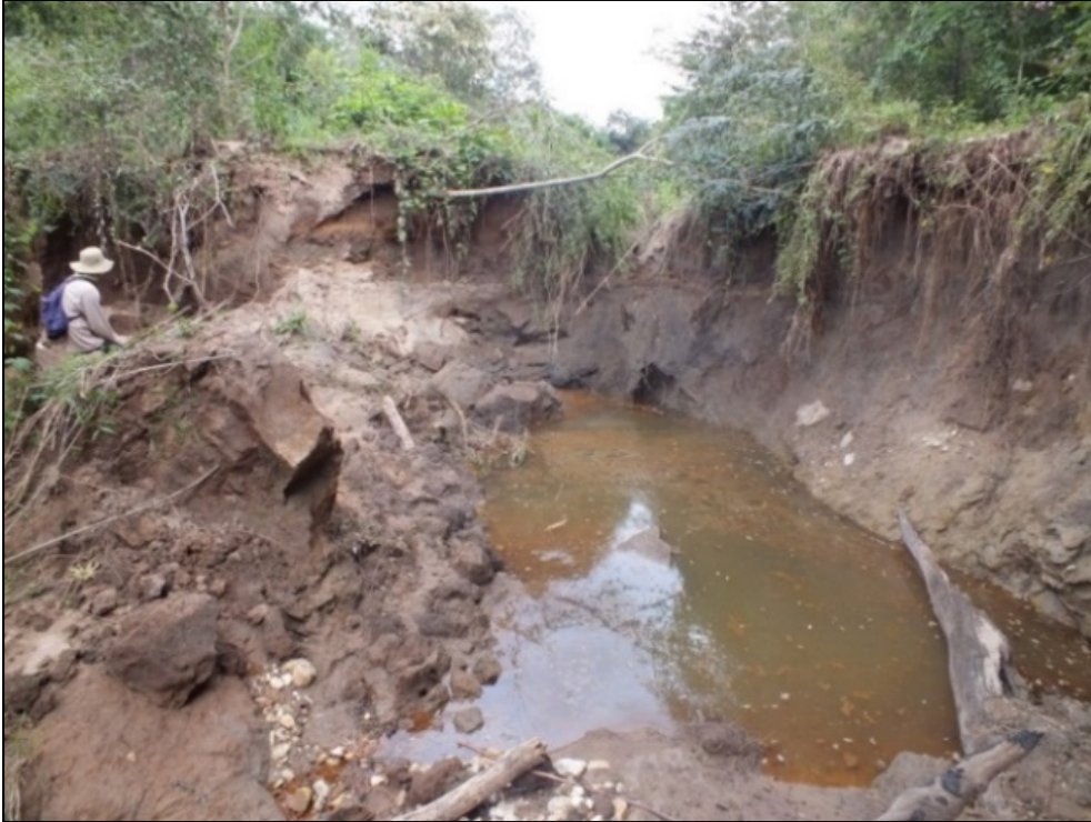
Foto 9.55 - Processo erosivo no leito do Córrego Diamantina Elaboração, IC Ambiental.
