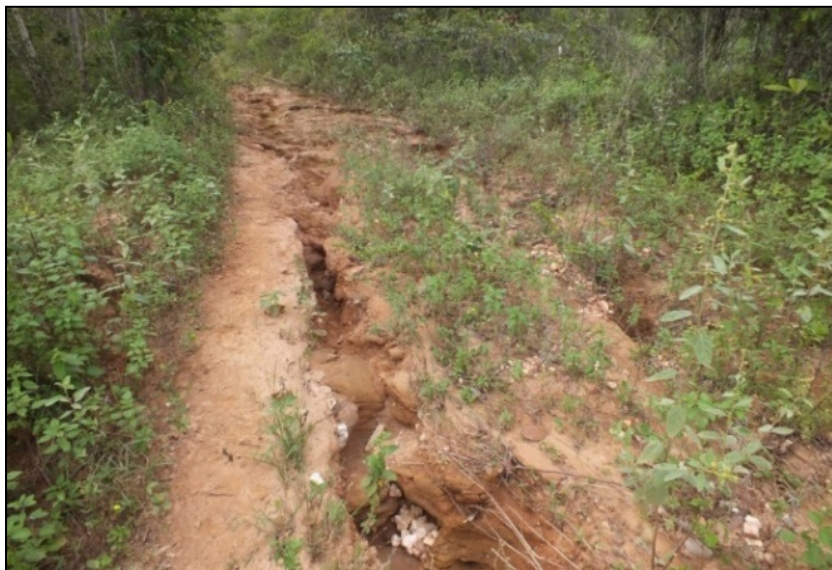
Foto 9.54- Processos erosivos, Ponto 2. Estágio avançado de erosão linear. Elaboração, IC Ambiental.
