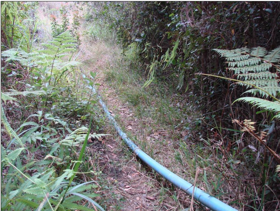
Foto 10.41 - Adução de água para a utilização em atividades de apoio à silvicultura
