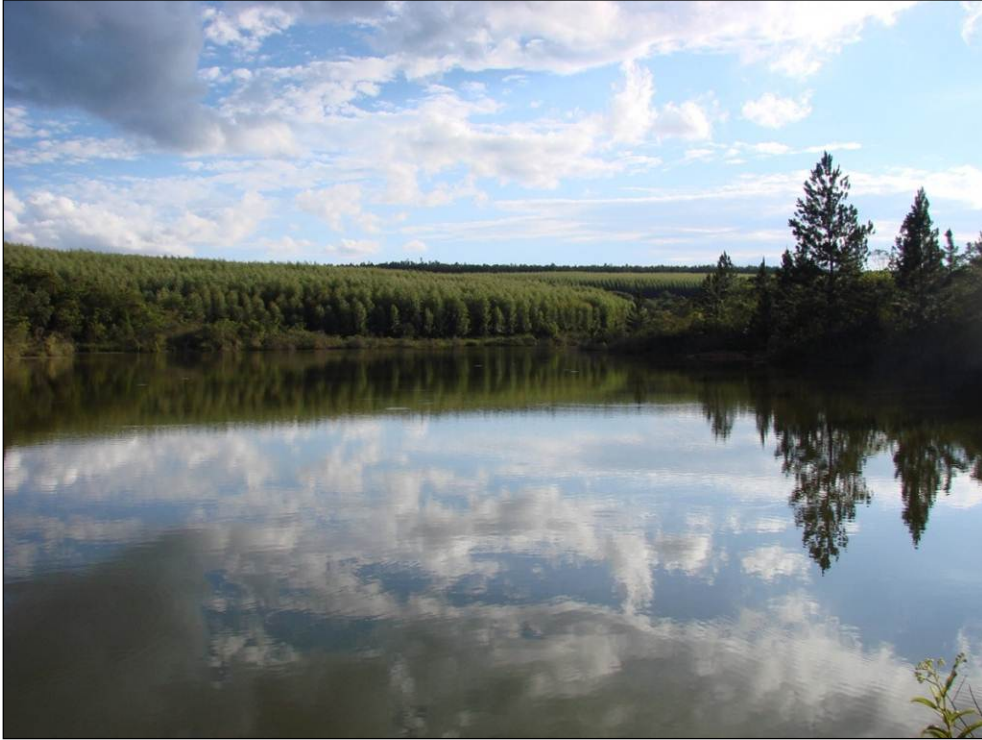
Foto 10.1 - Barramento situado no alto curso do córrego Lamarão, próximo à sua cabeceira, correspondendo à principal estrutura hidráulica identificada no leito principal do curso d'água
