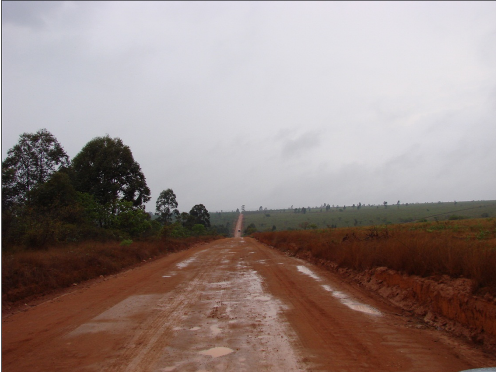
Foto 7.35 - Estrada que segue em direção à cidade de Josenópolis e a represa de Irapé, ponto onde a adutora de Irapé e a linha de transmissão passarão à direita (oeste). Notar pequeno declive do terreno ao fundo
