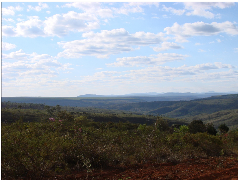
Foto 7.39 - Trecho final da adutora de Irapé e da linha de transmissão nos limites da área de estudo do complexo minerário, cabeceiras do córrego do Vale
