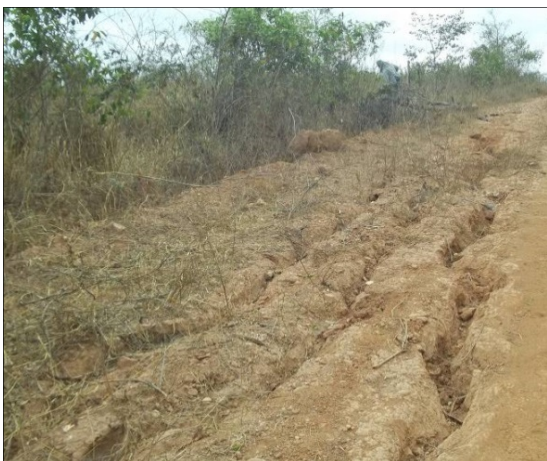
Foto 5.36 - Sulcos erosivos nas estradas da área da barragem do rio Vacaria
