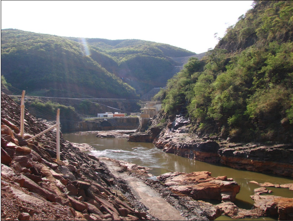
Foto 7.30 - rio Jequitinhonha imediatamente a jusante do barramento de Irapé, segmento confinado entre paredões
