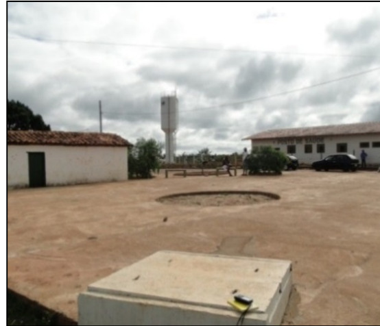
Foto 11.8 - Poço 2 (COPANOR) em Campo de Vacaria
