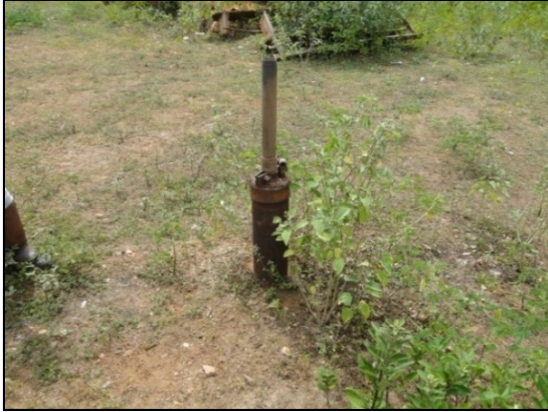
Foto 11.1 - Poço tubular tamponado
