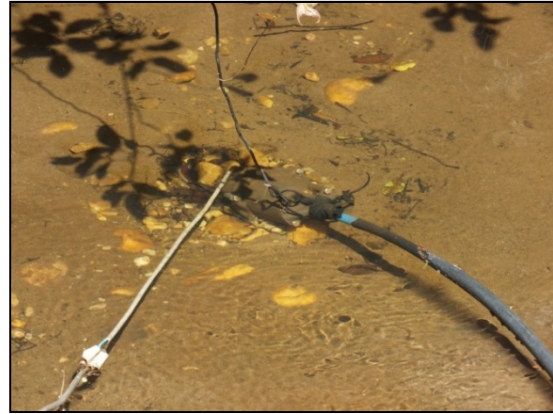
Foto 10.86 - Ponto de captação 4 - Córrego Água Branca
