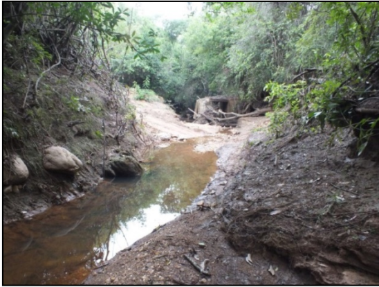
Foto 10.90 - Córrego Salobro, ao fundo ponte destruída pela força da enxurrada
