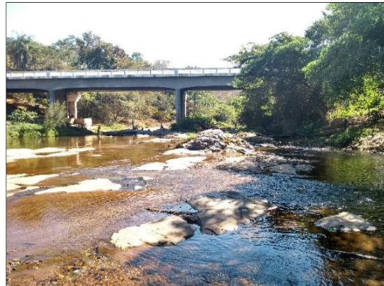
Foto 10.138 - Local da amostragem do ponto SAMP SUP13 - Rio Vacaria, a jusante da ponte - campanha de seca
