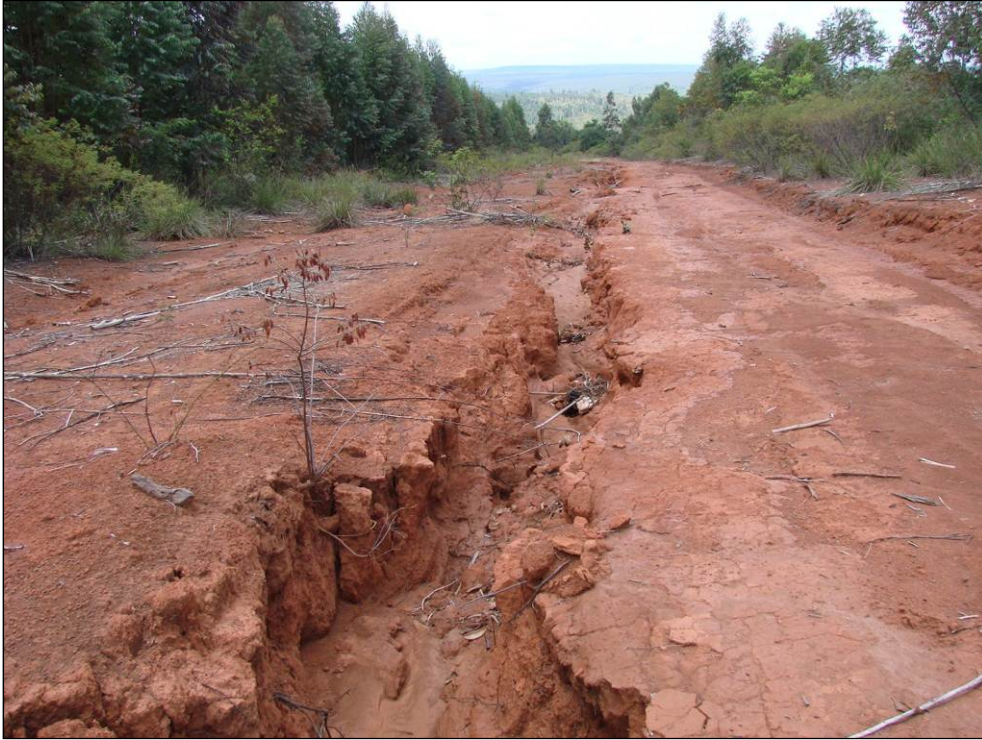
Foto 9.30 - Ravina desenvolvida sobre Latossolo Vermelho (LV), em estrada de acesso de eucaliptal, na área de influência direta da adutora de Irapé e linha de transmissão
