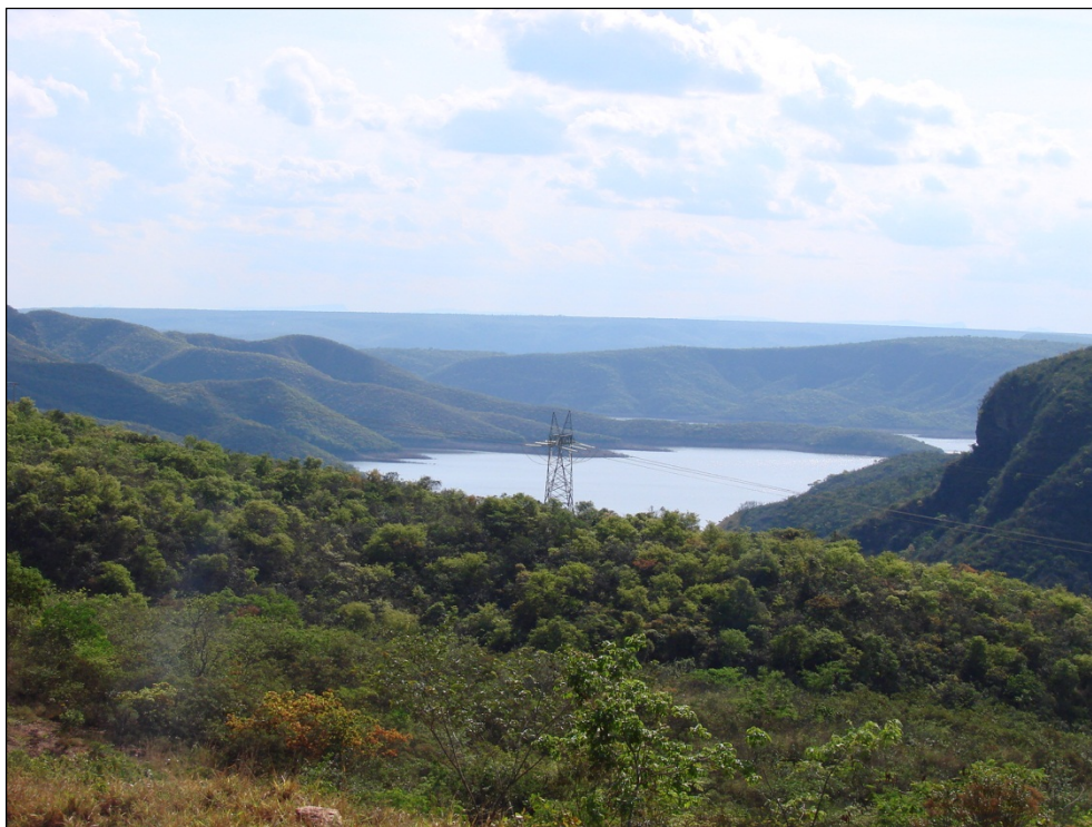
Foto 7.29 - Vale do rio Jequitinhonha com destaque para o lago da usina de Irapé, ponto inicial da adutora de Irapé
