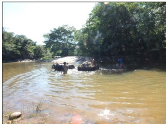
**Foto 6.1.7-14 - Extração de areia de forma manual sendo retirada por carro de bois, à jusante da queda d'água**
