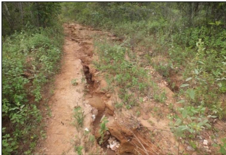
**Foto 6.1.11-12 - Processos erosivos, Ponto 2. Estágio avançado de erosão linear**
