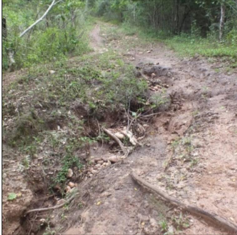
**Foto 6.1.11-11 - Processos erosivos em via local tipicamente na forma de sulcos e ravinas**
