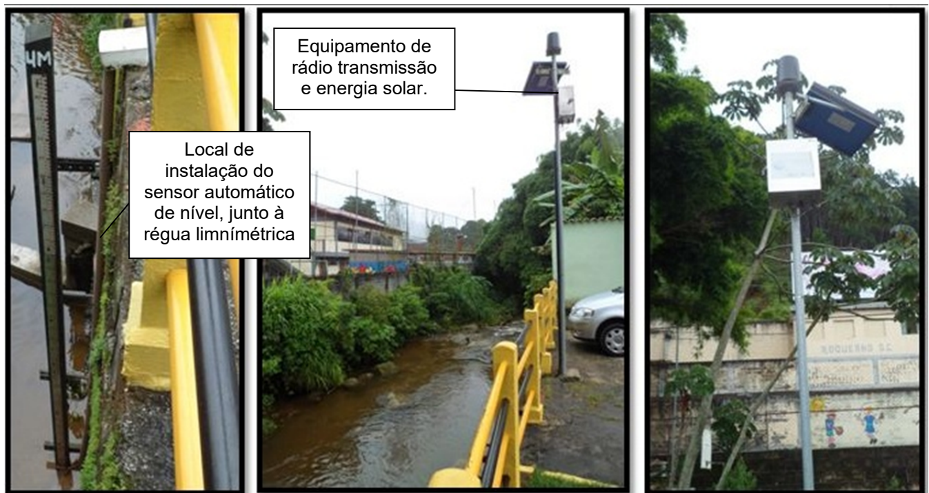
Figura 5.3.3.1 –Exemplo de instalação de sensor de nível.
