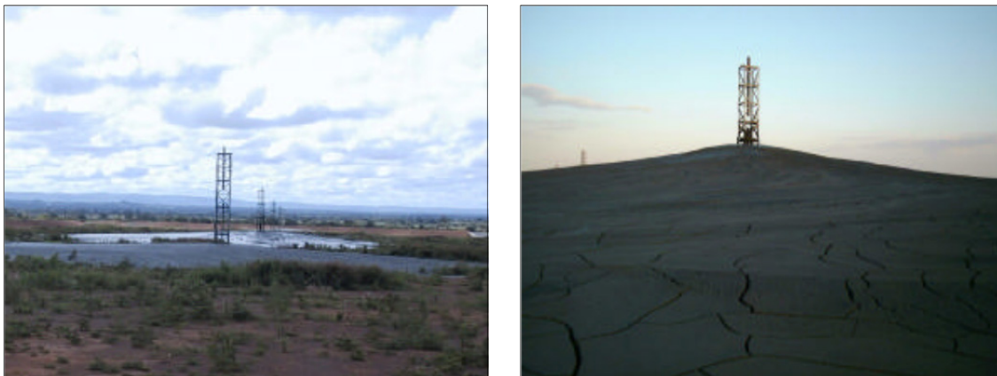
FIGURA 4.1.2-6 - Deposição de rejeito em pasta - PASTE, Bulyanhulu Gold Mine, Tanzânia
