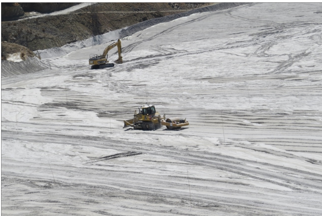
FIGURA 4.1.2-10 - Compactação do rejeito grosso para alteamento do talude de jusante
