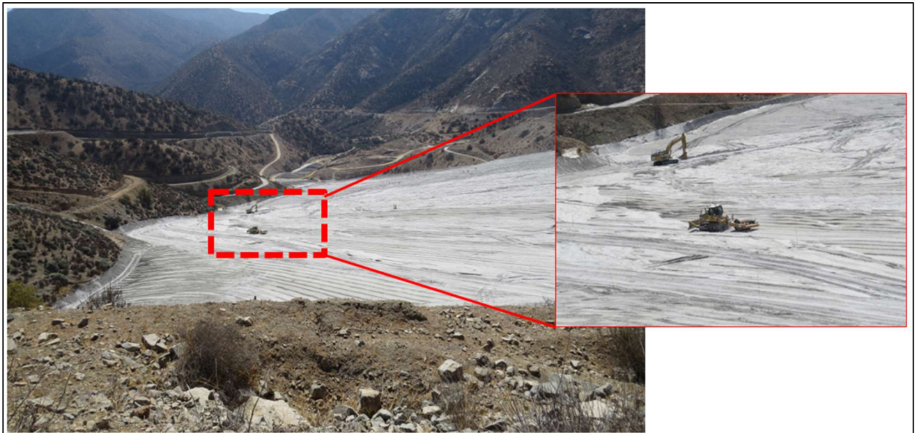
Figura 7.1.2.10 – Compactação do rejeito grosso para alteamento do talude de jusante.
