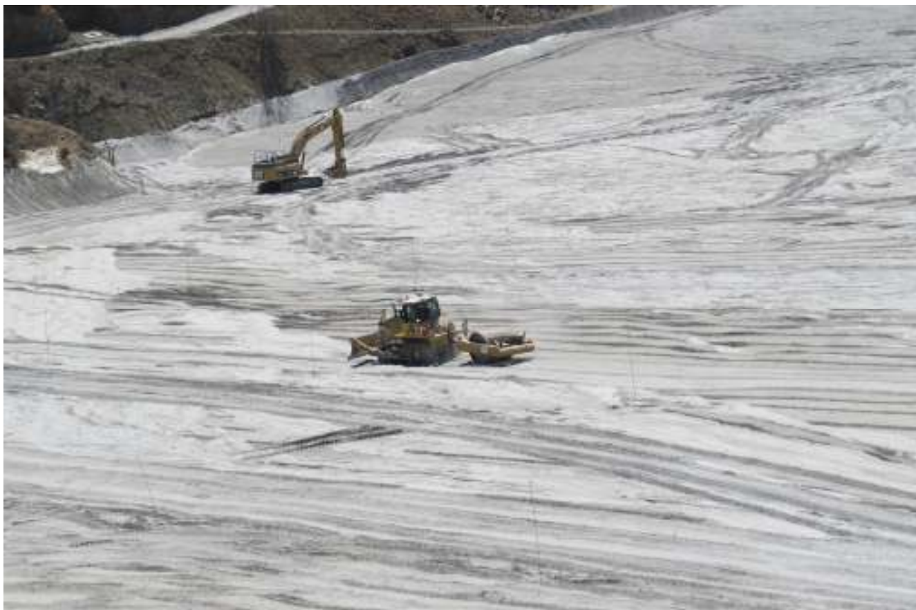
Figura 7.2.1.1 – Compactação do rejeito grosso para alteamento do talude de jusante.
