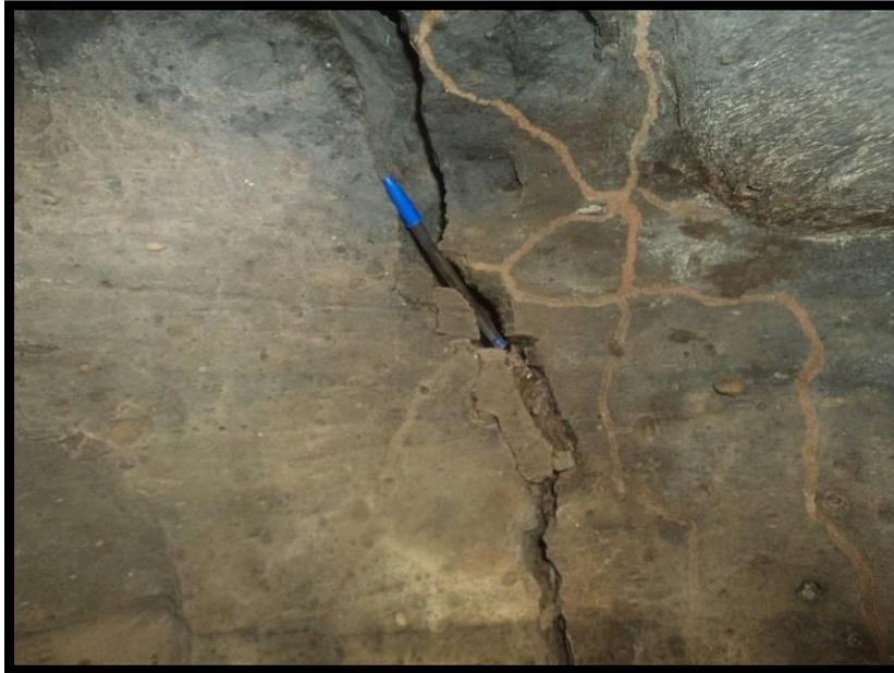
**AB VAC 22. Detalhamento de fratura e caminho de cupim inativo na parede direita da cavidade.**
