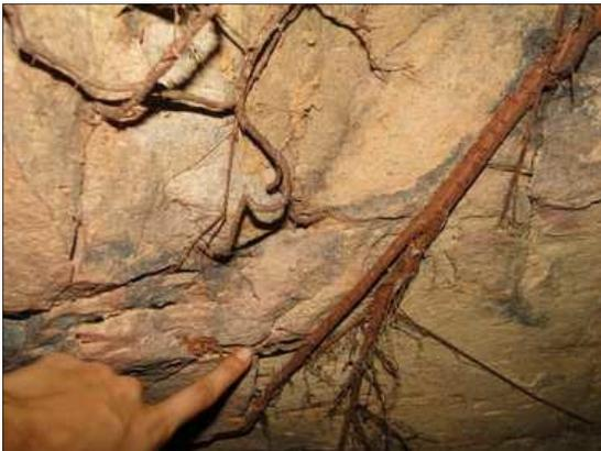
**Foto 3.3-12 - Raízes observadas nas paredes e em parte do teto da VAC\_10**
